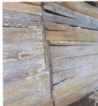
Foto 4: Sustitucion de horcones, debido que estan afectados por la humedad del suelo.
