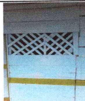
Foto 6: Sustitucion de ventanas, cambio de ventanas debido que poca ventilacion en el interior del aula.
