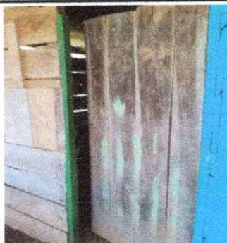
Foto 5: Se observa la puerta, de la direccion en una mala condicion no se cierra correctamente
